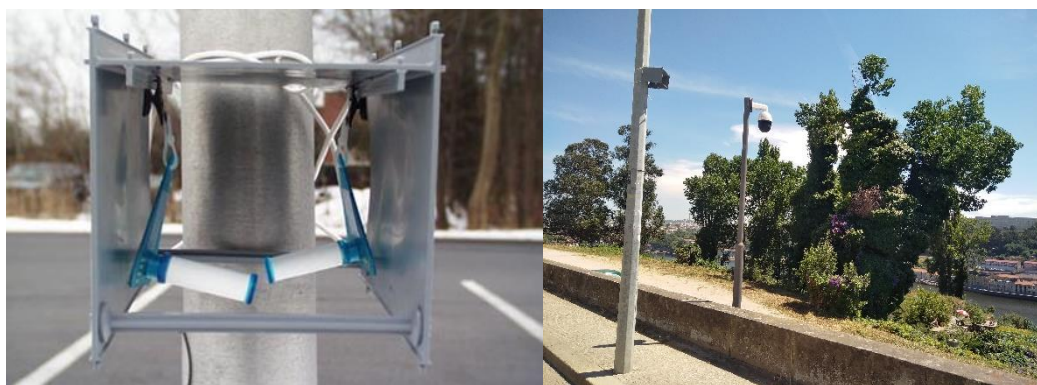
Figura 4 – Instalação de tubos de difusão no terreno
