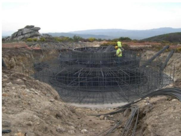
Fotografia 3 - Execução da armadura da fundação do aerogerador
