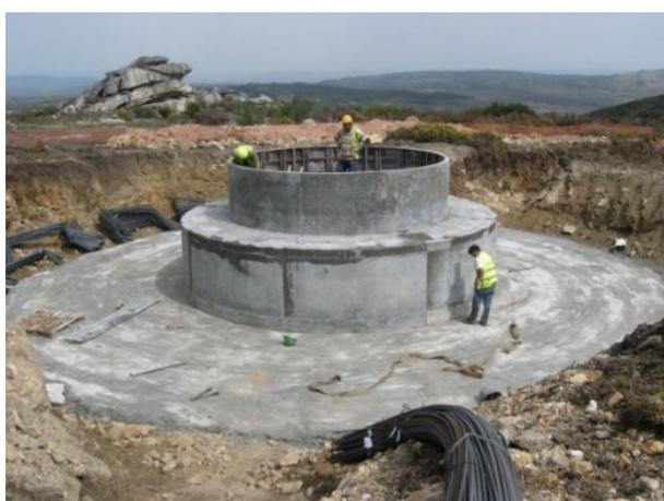
Fotografia 5 - Betonagem da fundação do aerogerador
