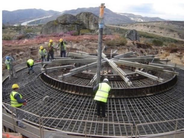
Fotografia 4 - Betonagem da fundação do aerogerador
