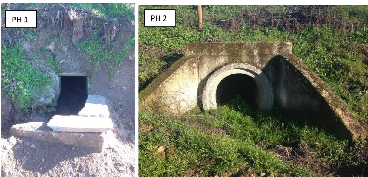
**Figura 7** – Passagens hidráulicas sob a linha férrea e EM15 para a qual serão encaminhadas as águas pluviais oriunda da nova área industrial.
