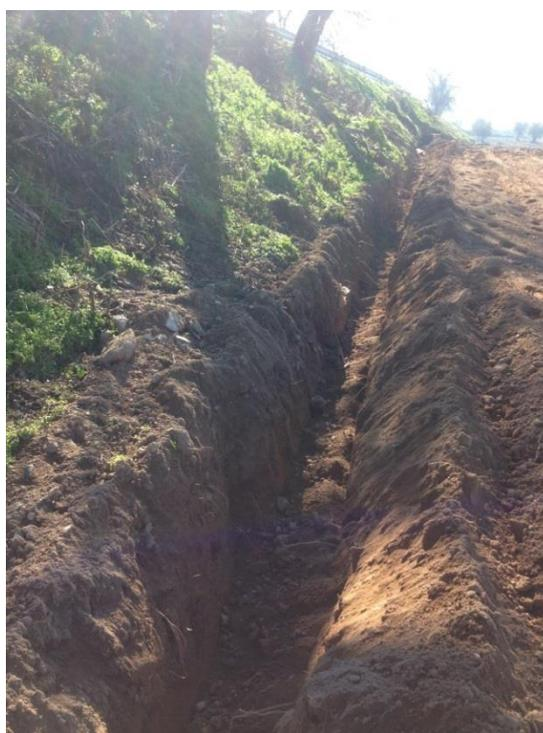
**Figura 5** – Vala de escoamento das águas de escorrência.
