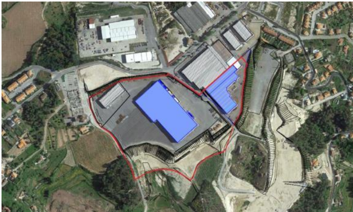
Figura 4 - Localização da METALOCARDOSO sobre fotografia aérea (fonte: Google Earth ).
