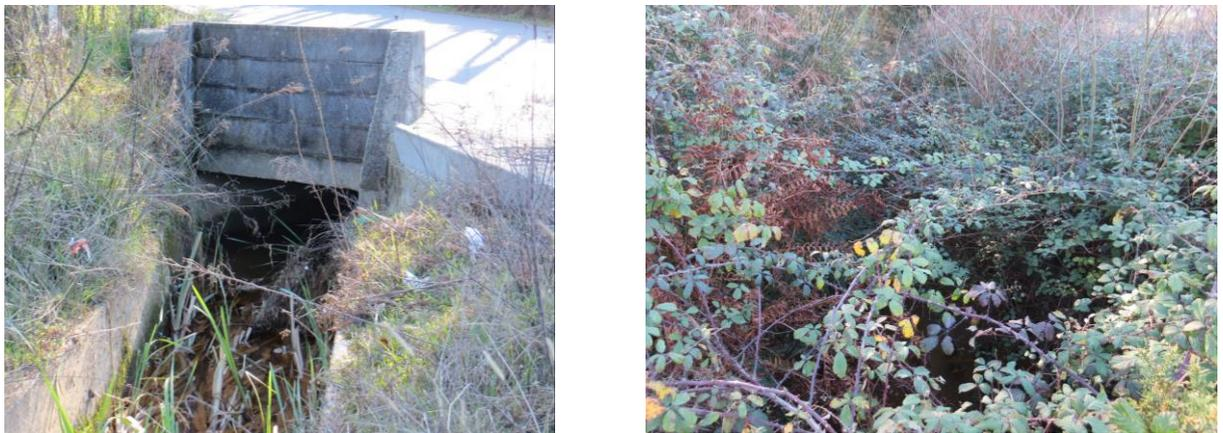
**Figura 6** – Presença de vegetação a obstruir o canal de drenagem a montante (esquerda) e a jusante (direita) da passagem hidráulica sob o CM 1184.
