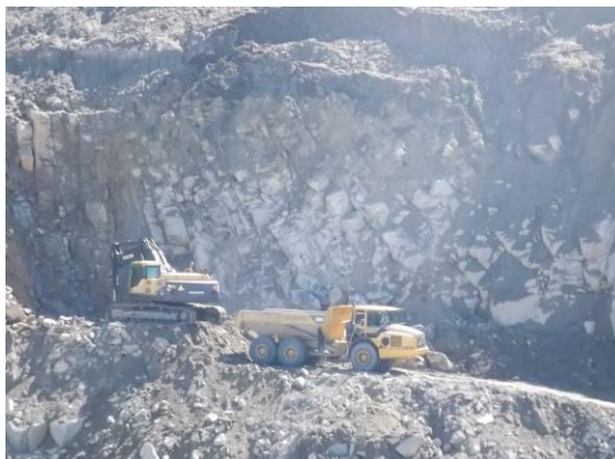
Fotografia 3 - Carga e transporte na frente de desmonte.
