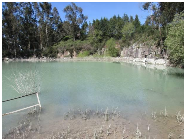
Fotografia 6 - Bacia de decantação.
