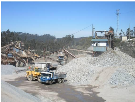
Fotografia 8 - Carga dos materiais britados para transporte até ao destino final.
