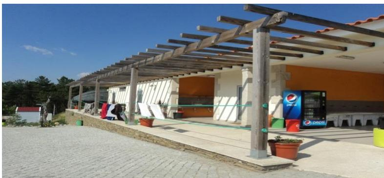
**Figura 55 - Piso em calçada de cubo de granito**
