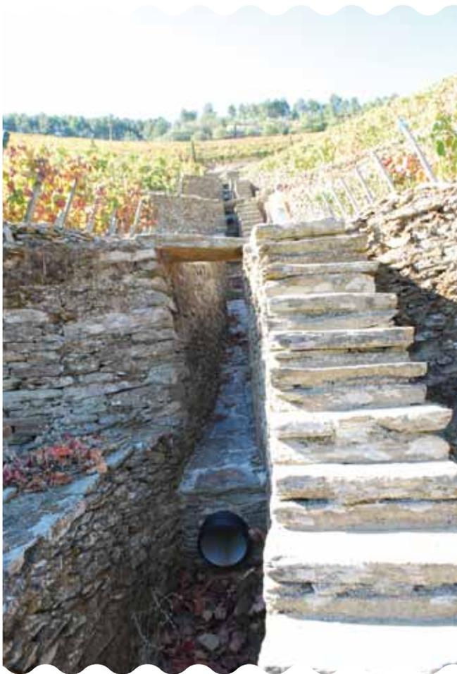
FIGURAS 8A E 8B - Correto sistema de drenagem ao longo de uma linha de água, de origem pré-filoxérica (imagem da esquerda) e sua destruição a montante para instalação de patamares mecanizáveis (imagem da direita), o que veio a refletir-se em graves problemas de erosão nos seus taludes.
