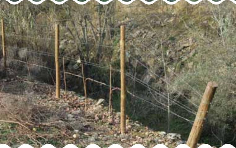
FIGURAS 25A E 25B - Fixações de cabeceira: escora de madeira com “esticador” e mobilidade de arames com cadeado (em cima); escora de 2m enterrada a 0,8 – 1,0m para diminuição das forças de tensão na cabeceira e para fácil mobilidade dos arames duplos (em baixo).
