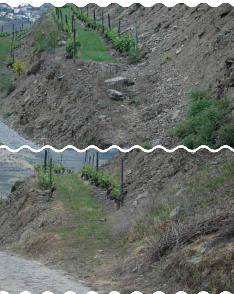
FIGURAS 11A E 11B - Exemplos de ligações, incorretas (imagem superior) e corretas (imagem inferior), entre os patamares e estradas de circulação.
