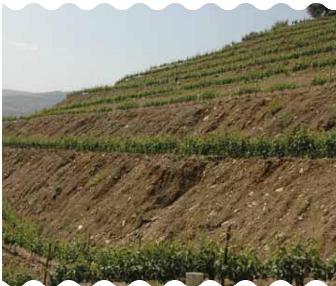
FIGURA 4 - Exemplo de ravinamento em taludes de alta dimensão com deficiente sistema de controlo contra erosão.
