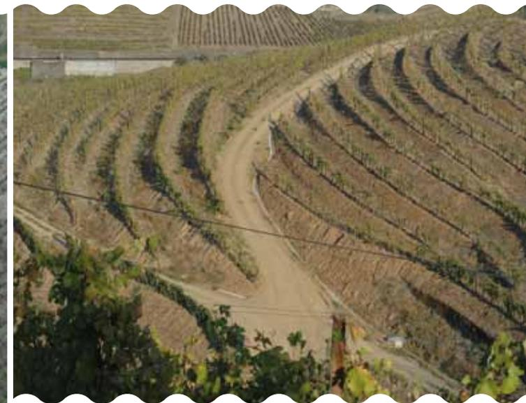
FIGURA 14 - Patamares de 1 bardo. A drenagem das águas é assegurada quer pela inclinação longitudinal dos patamares quer através das manilhas e colectores nas estradas de acesso.
