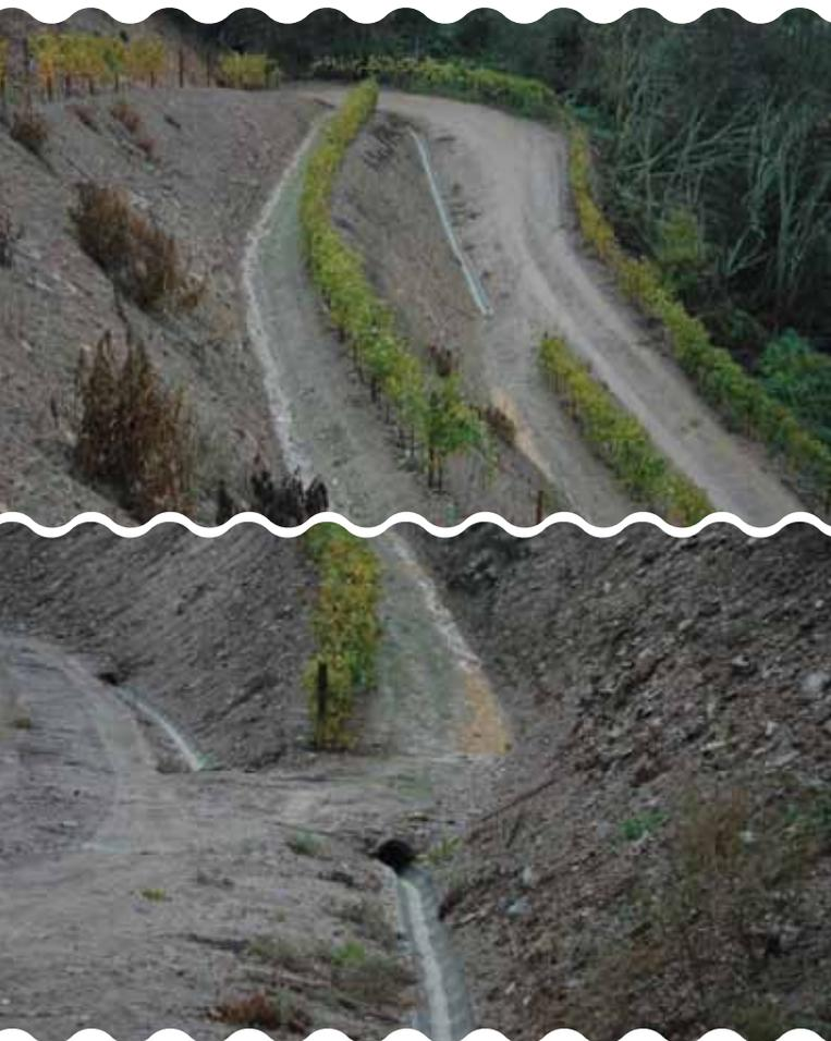
FIGURAS 7A E 7B - Drenagem com meias manilhas nas estradas de acesso aos patamares de 1 bardo, cuja inclinação longitudinal e para o bordo interior permite que as águas escorram para a rede de drenagem da parcela, evitando assim a ocorrência de ravinamentos nos taludes (Quinta da Romaneira).
