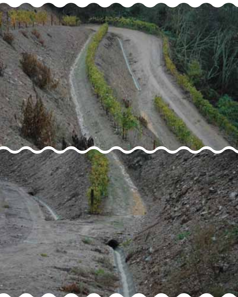
FIGURAS 7A Y 7B - Drenaje a través de canales en los caminos de acceso a las terrazas con 1 hilera, cuya inclinación longitudinal y hacia el borde interior permite que las aguas escurran hacia la red de drenaje de la parcela, evitando así la ocurrencia de surcos en los taludes (Quinta da Romaneira).
