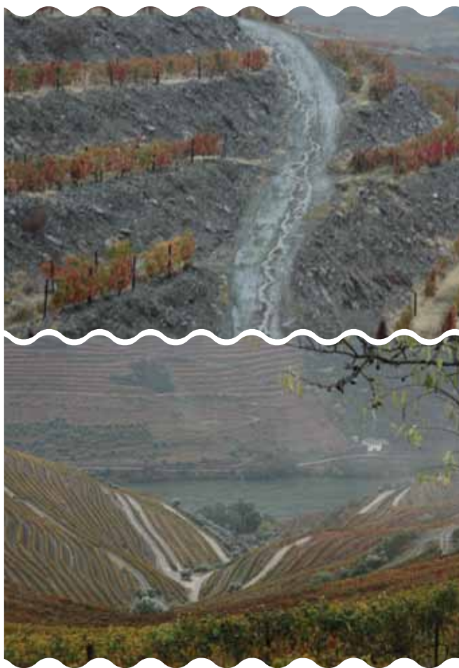
FIGURAS 12A Y 12B - El trazado de las terrazas siguiendo las curvas de nivel ocasiona acumulaciones de aguas de lluvia en determinados puntos, provocando problemas de erosión en los taludes y caminos de acceso.
