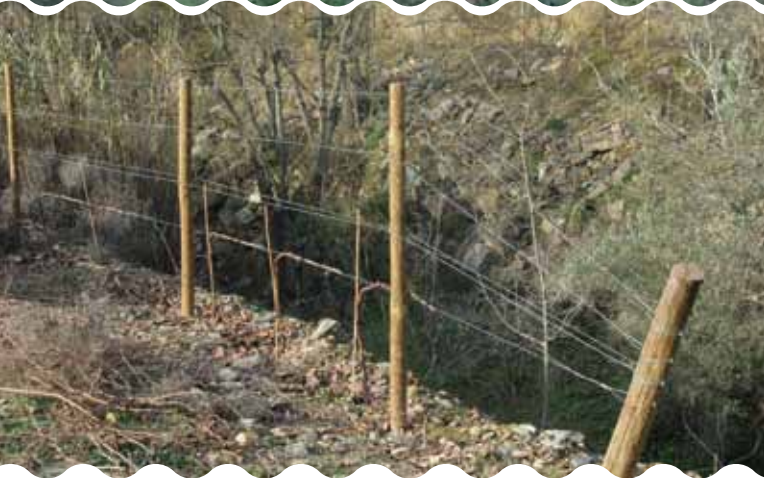
FIGURAS 25A Y 25B - Anclajes de cabecero: estaca de madera con tensor y movilidad de alambres con cadena (fotografía arriba); poste de anclaje de 2m enterrado 0,8-1,0m para disminuir las fuerzas de tensión en el cabecero y facilitar la movilidad de los alambres dobles (fotografía abajo).
