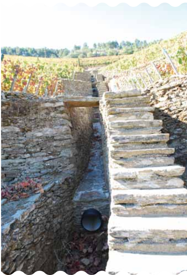
FIGURAS 8A Y 8B - Correcto sistema de drenaje a lo largo de una línea de agua, cuyo origen se remonta a antes de la filoxera (fotografía de la izquierda). Destrucción de este sistema de drenaje para la creación de terrazas que permitan la mecanización (fotografía de la derecha), lo cual ha traído como consecuencia graves problemas de erosión en sus taludes.
