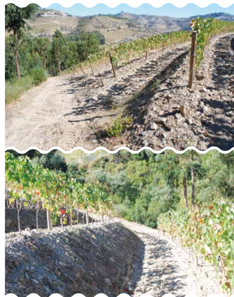
FIGURAS 16A Y 16B - Terrazas angostas trazadas con pendiente en el sentido longitudinal (3%) y hacia el borde interior de la terraza, lo que permite el escurrimiento de las aguas en el sentido de las calles de acceso, con disminución importante de los problemas de erosión (Quinta da Casa Nova).
