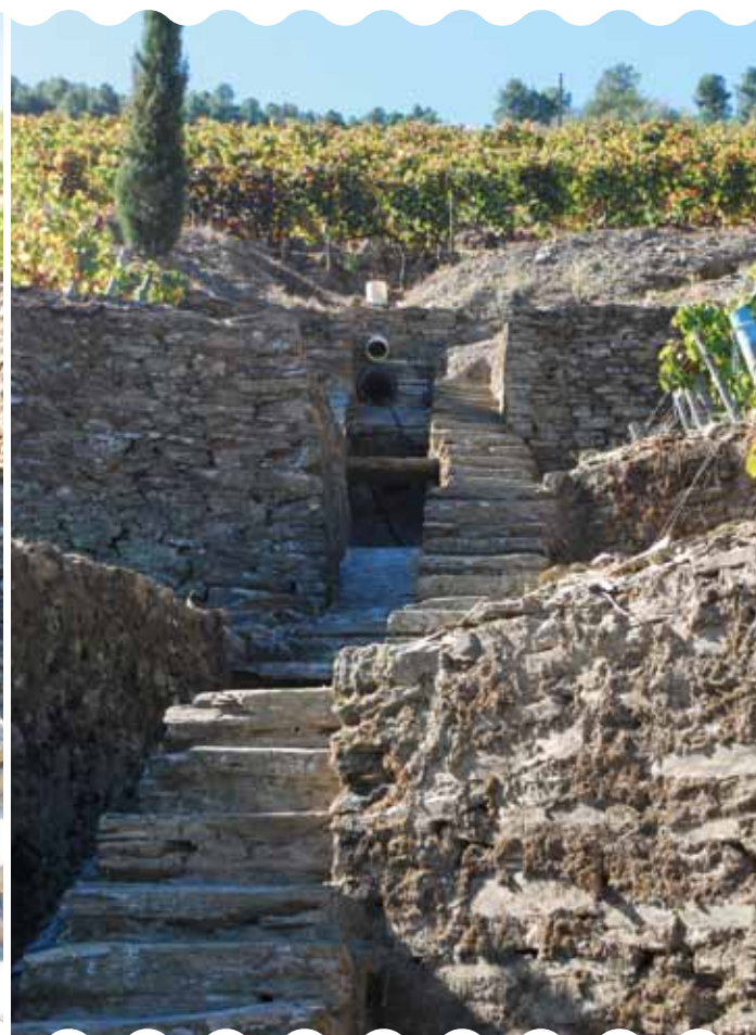
FIGURAS 8A Y 8B - Correcto sistema de drenaje a lo largo de una línea de agua, cuyo origen se remonta a antes de la filoxera (fotografía de la izquierda). Destrucción de este sistema de drenaje para la creación de terrazas que permitan la mecanización (fotografía de la derecha), lo cual ha traído como consecuencia graves problemas de erosión en sus taludes.
