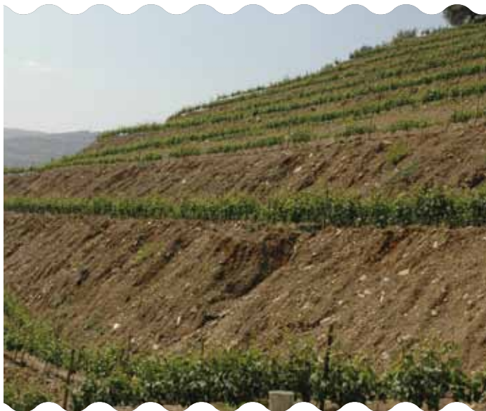
FIGURA 4 - Ejemplo de surcos en taludes de gran dimensión con deficiente sistema de control de la erosión.
