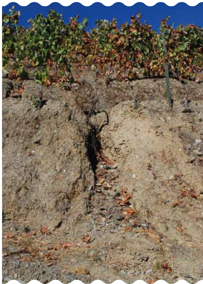
FIGURAS 15A Y 15B - Terrazas angostas cuya horizontalidad a veces provoca problemas de erosión en los taludes debido a la ausencia de un drenaje eficaz en el sentido longitudinal de la terraza.
