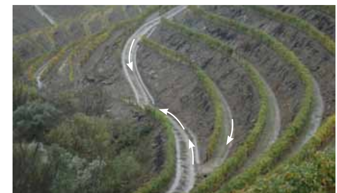
Drenagem correta com manilhas apenas nos caminhos principais e declive longitudinal e lateral nos patamares.
