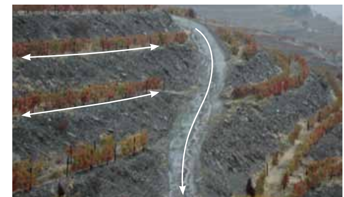
Drenagem incorreta. Patamares horizontais dificultam a saída das águas para o caminho, desviando-as por vezes para os taludes, e faltam manilhas no caminho principal.
