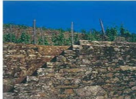
A comunicação entre os socalcos faz-se por rampas ou escadas, que podem estar embutidas na espessura do muro ou serem salientes e maciças, ou ainda serem formadas pela colocação de lajes
