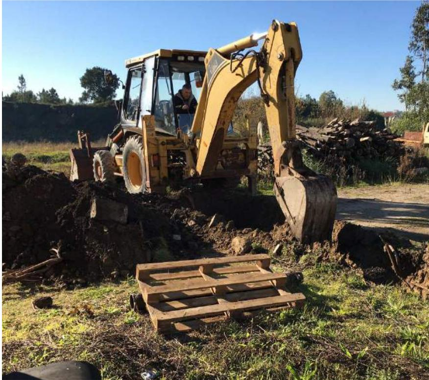
Figura 3.14 – Abertura de poço com retroescavadora
