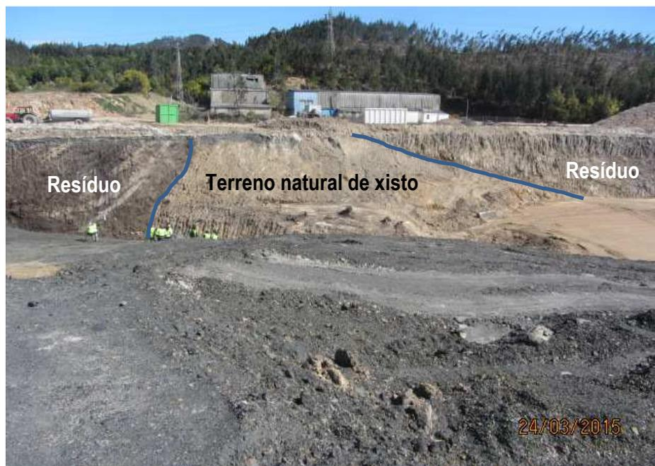
Figura 3.16 – Taludes de escavação com resíduos separados por talude de escavação sem resíduos (1.ª Fase)
