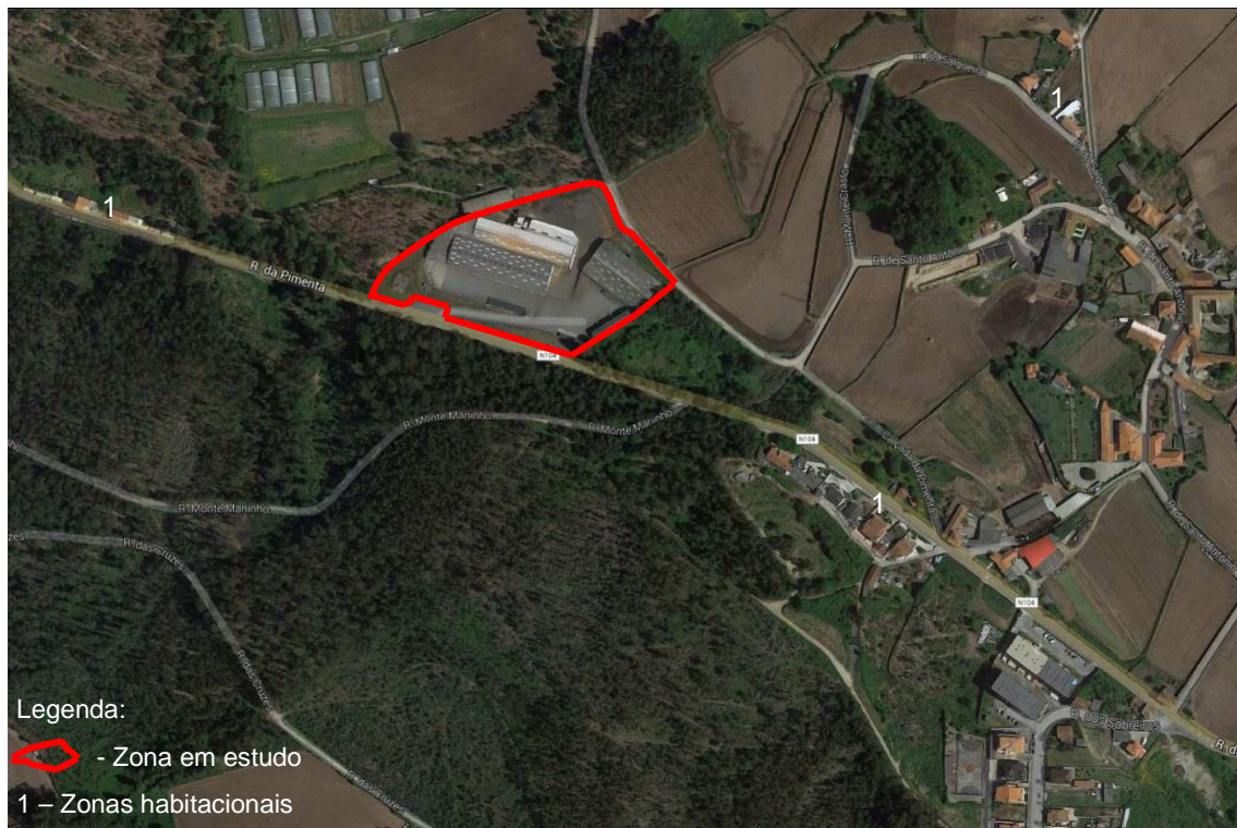
Figura 1 - (Figura 3 do EIA) Localização da ZINCONORTE sobre fotografia aérea, com identificação de zonas habitacionais mais próximas.
