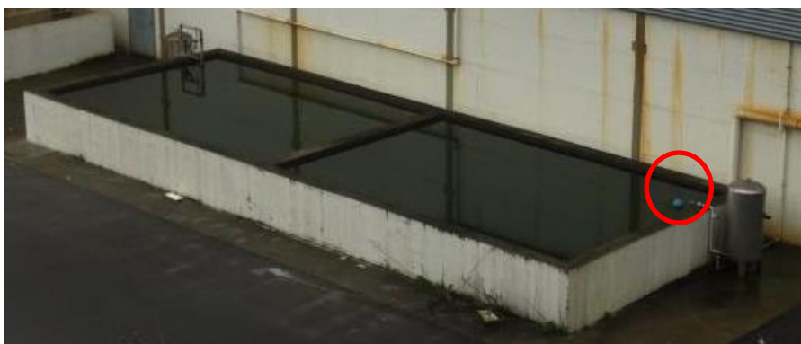
Figura 14 – Depósitos de receção de água para o processo produtivo.
