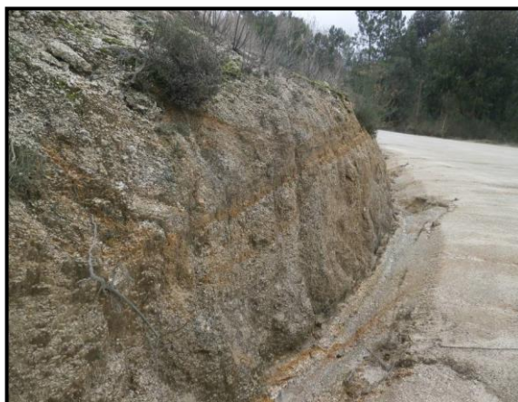
Figura 22 - Observação do talude, na estação #1 com evidência das zonas de circulação que se apresentam oxidadas.
