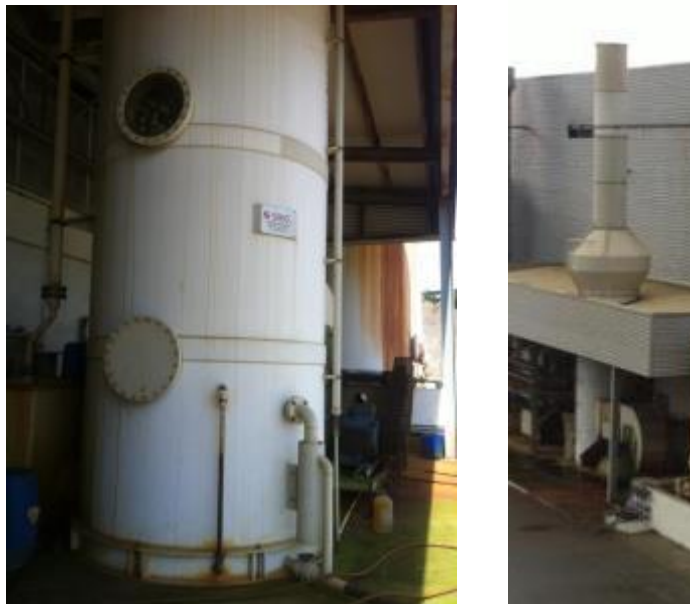
Figura 11 – Lavador de gases.
