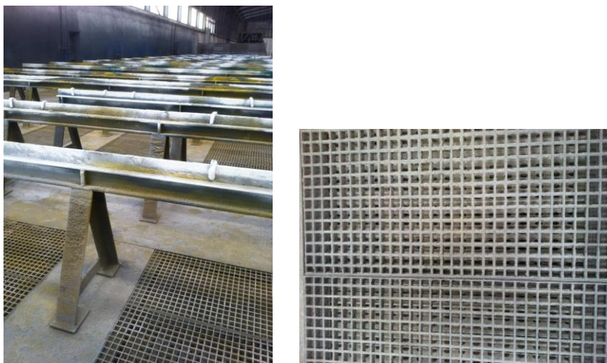
Figura 15 – Processo de pintura e pormenor dos filtros secos instalados na parte inferior do pavimento.
