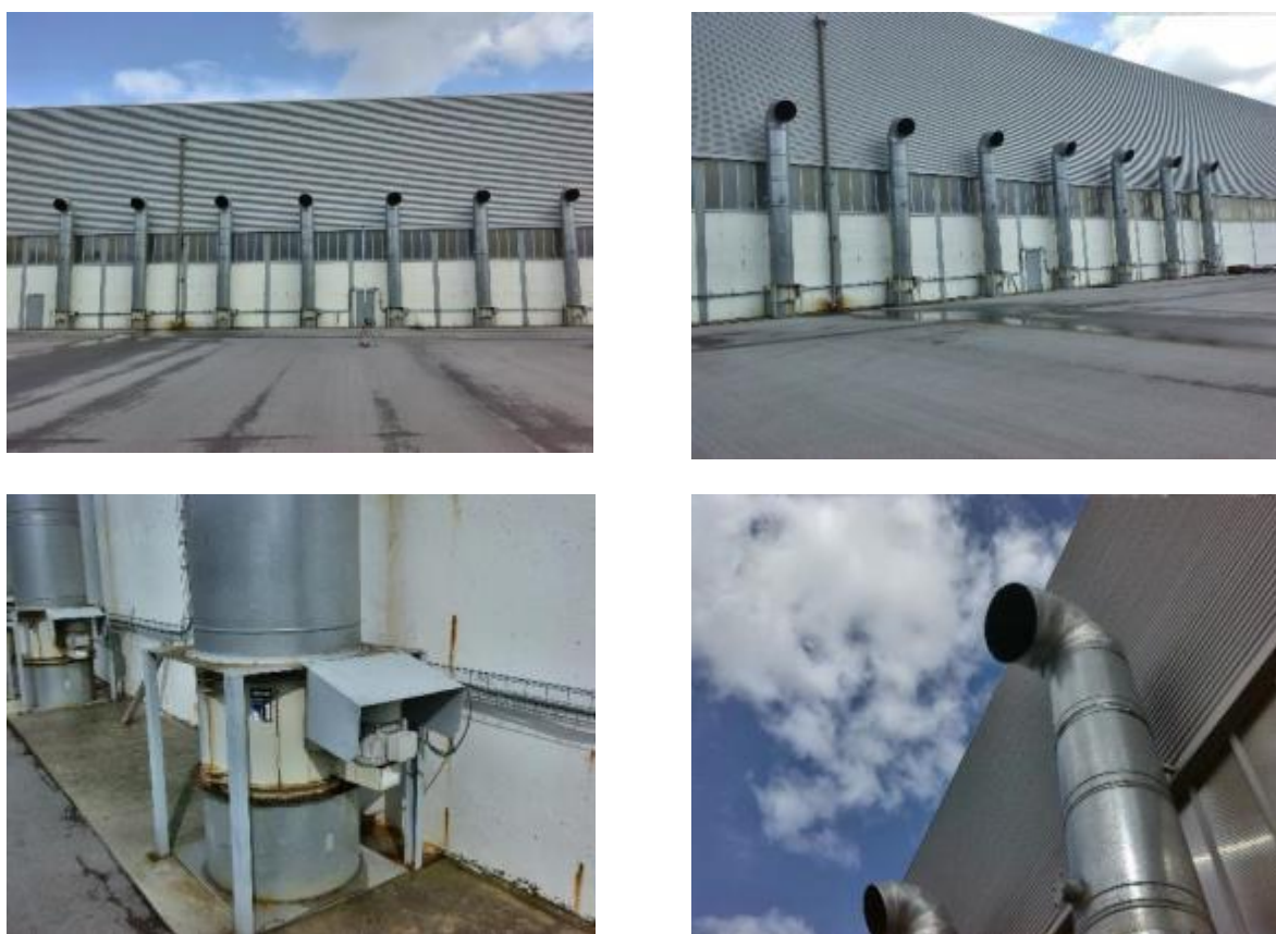
Figura 94 – Apontamento fotográfico dos extratores associados à pintura líquida.
