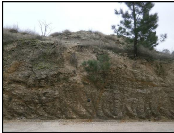
Figura 21 - Observação do talude a oeste da área em estudo, representando a estação #1.
