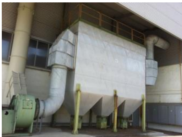
Figura 12 – Sistema de filtro de mangas.
