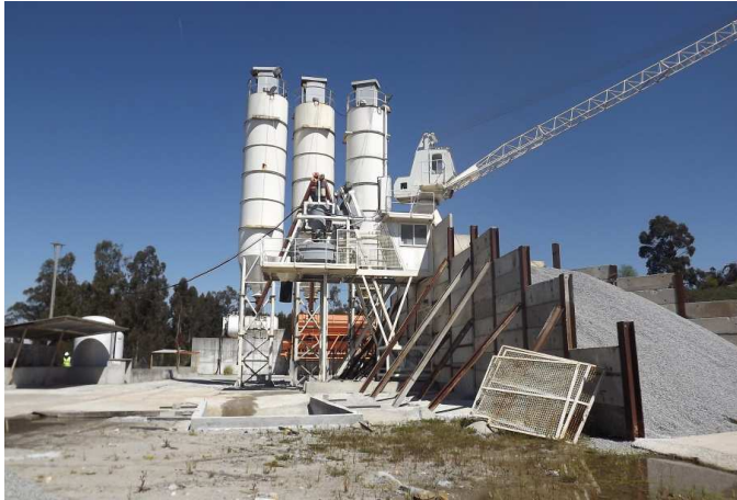
Fotografia 3.6 - Central de betão instalada na pedreira.
