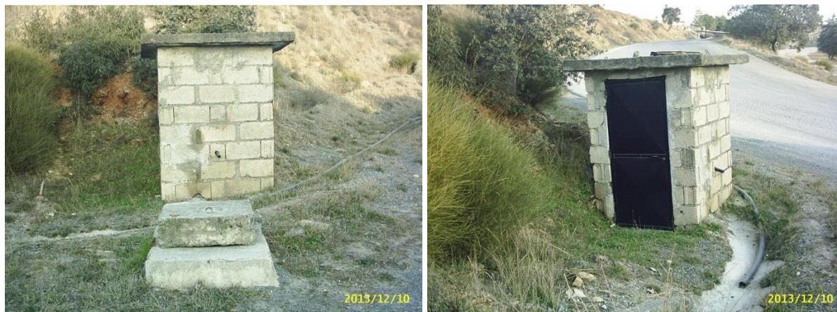
**Figura n.º 48:** Captação da água subterrânea
