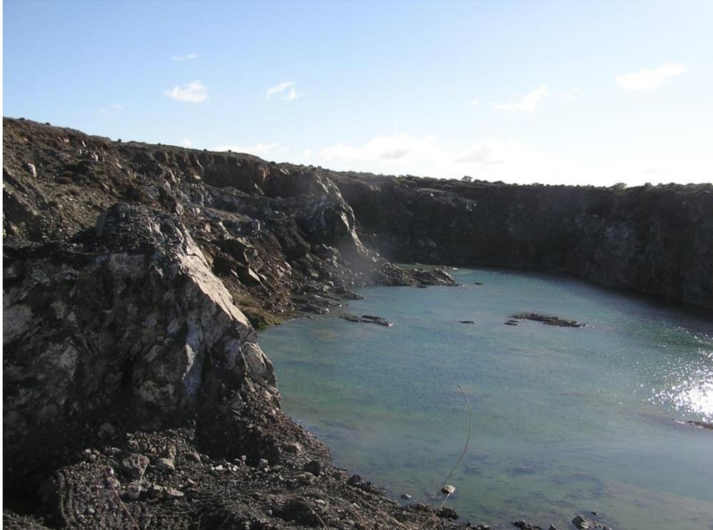
**Figura n.º 89:** Intersecção da escavação com o nível freático
