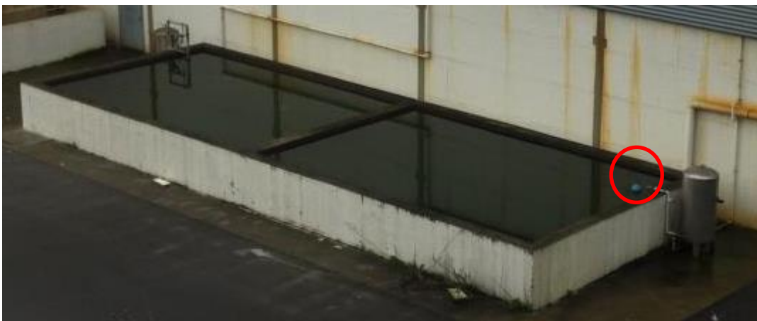
Figura 5 – Tanque de receção de água para o processo produtivo.
