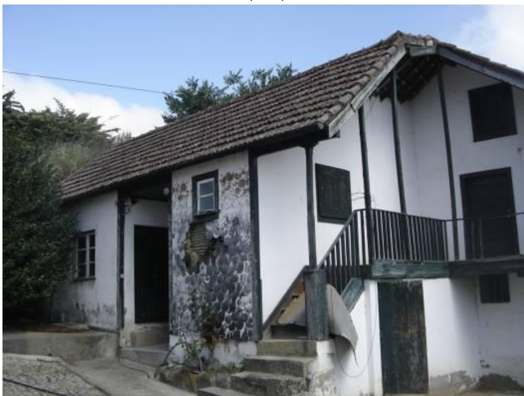
Foto 2 – Quinta de Santa Maria – Edifício de apoio
