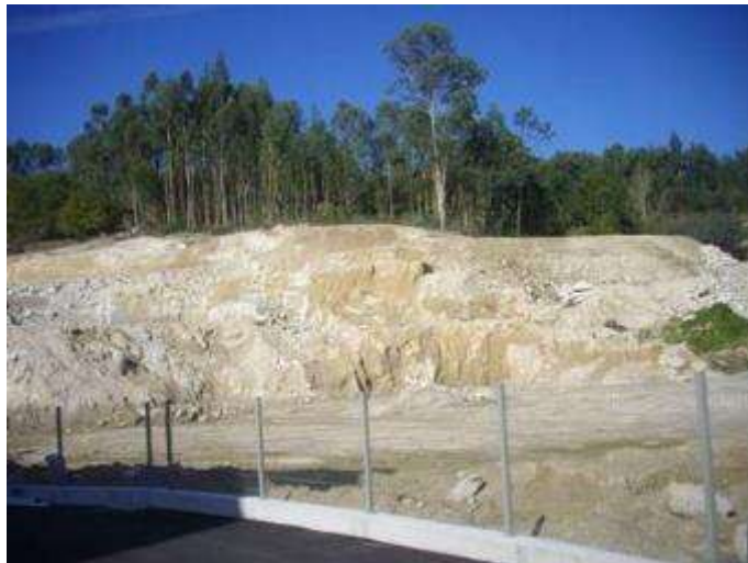
Figura 15 – Observação de taludes de escavação na envolvente exterior da Eurocast Portugal Viana
