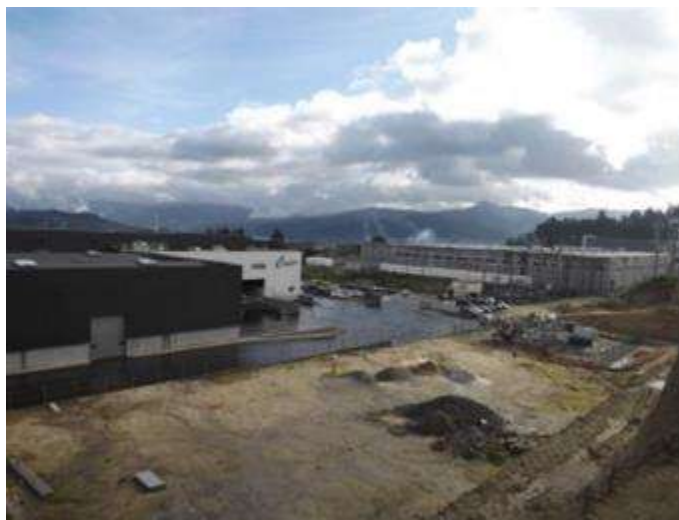
Figura 108 – Edifício da Eurocast e desaterro da área a Oeste do edifício (visto de Este para Oeste).
