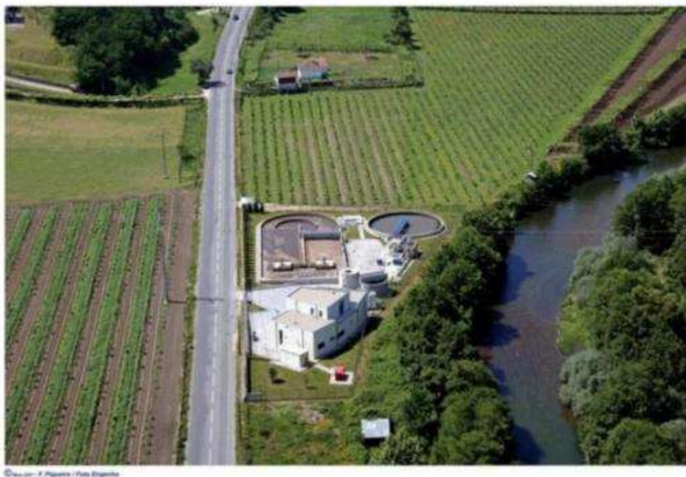
Figura 54 – Vista aérea da ETAR de Arcos de Valdevez
