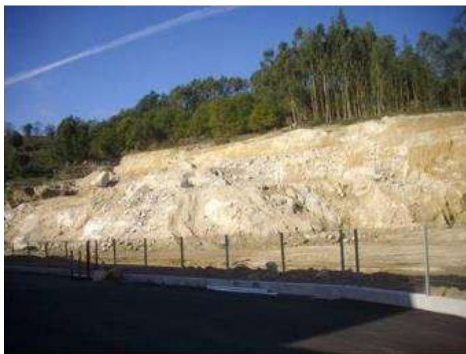
Figura 16 – Observação da fina camada da zona superficial, da camada de saibro granítico na zona intermédia e profundidade do maciço rochoso
