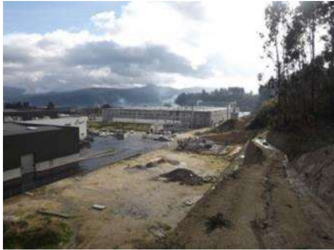
Figura 109 – Pormenor da área desaterrada a Oeste da implantação do edifício.
