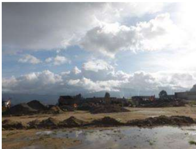
Figura 114 – Áreas aterradas e desaterradas a Este do edifício.
