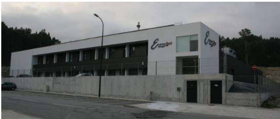
Figura 80 – Fotografia da unidade industrial da Eurocast Portugal Viana
