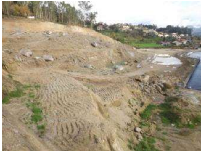
Figura 110 – Pormenor da área desaterrada a Norte da implantação do edifício.
