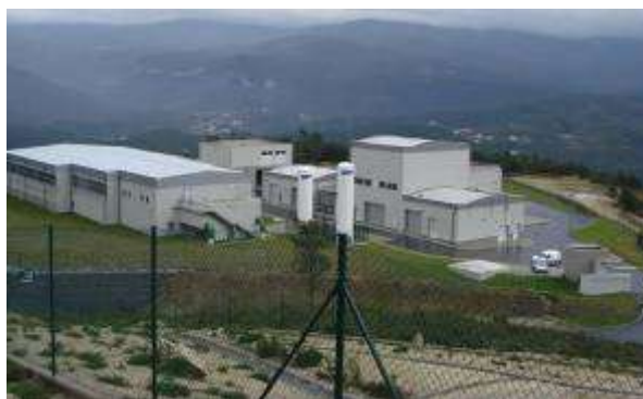
Figura 52 – Vista panorâmica da ETA de S. Jorge
