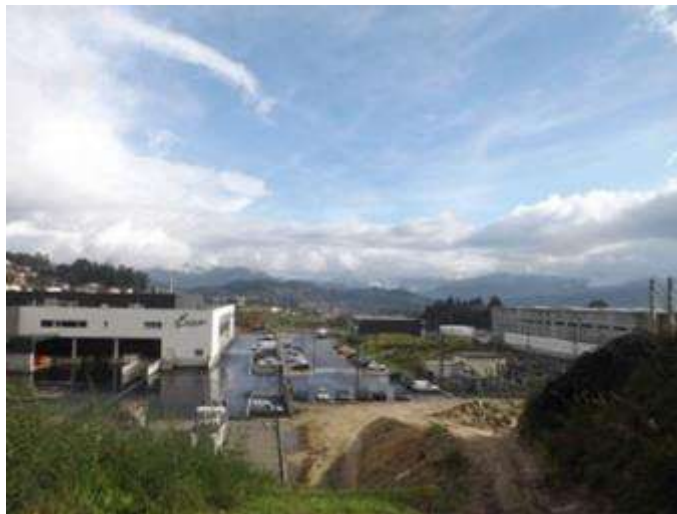
Figura 111 – Área a Sul do edifício – impermeabilizada e edificada.
