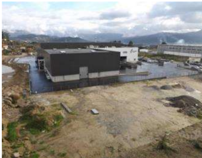
Figura 107 – Edifício da Eurocast e desaterro circundante (visto de Este para Oeste).
