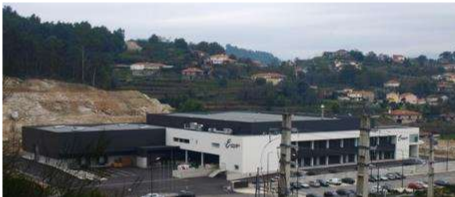
Figura 180 – Vista da zona de intervenção
