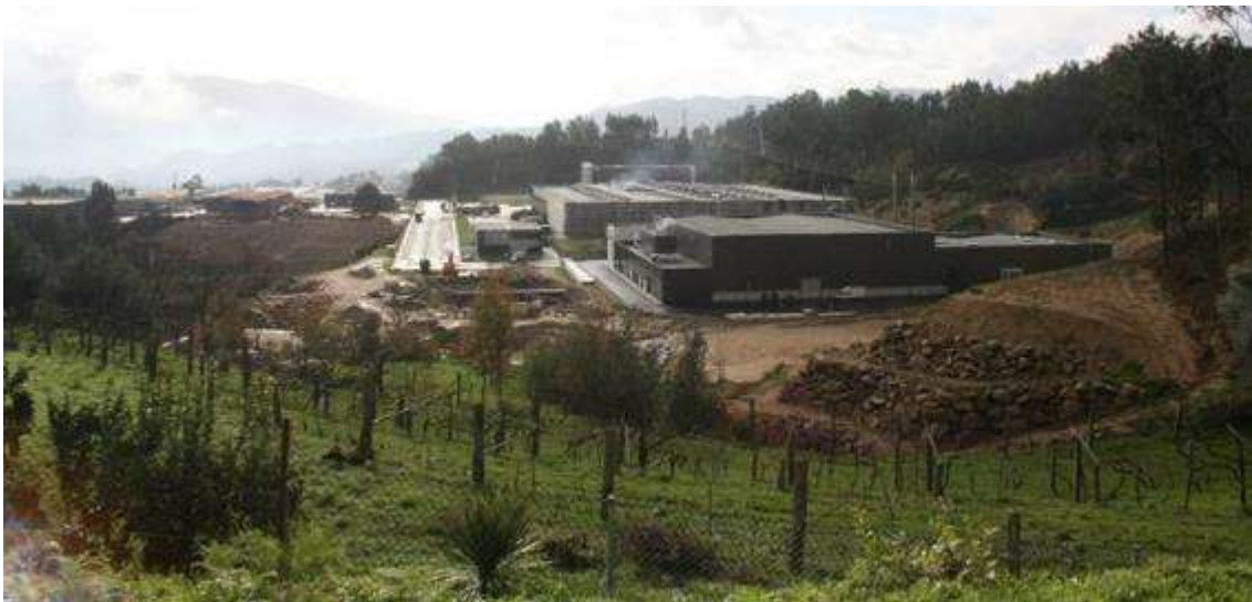
Figura 212 – Fotografia da Eurocast Portugal Viana e envolvente próxima (no sentido norte / sul).
