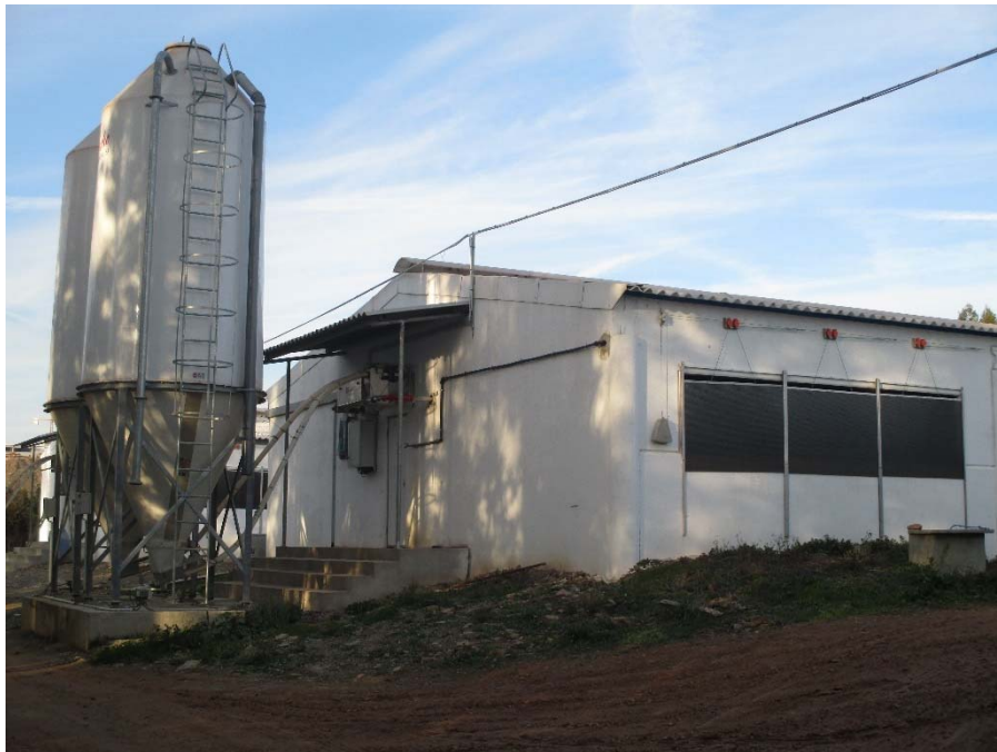
Figura II.3 - Silos de armazenamento de ração.
