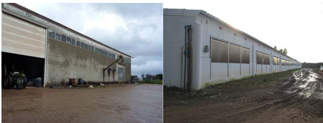
Figura III. 31 - Exemplos dos edifícios existentes no local.
