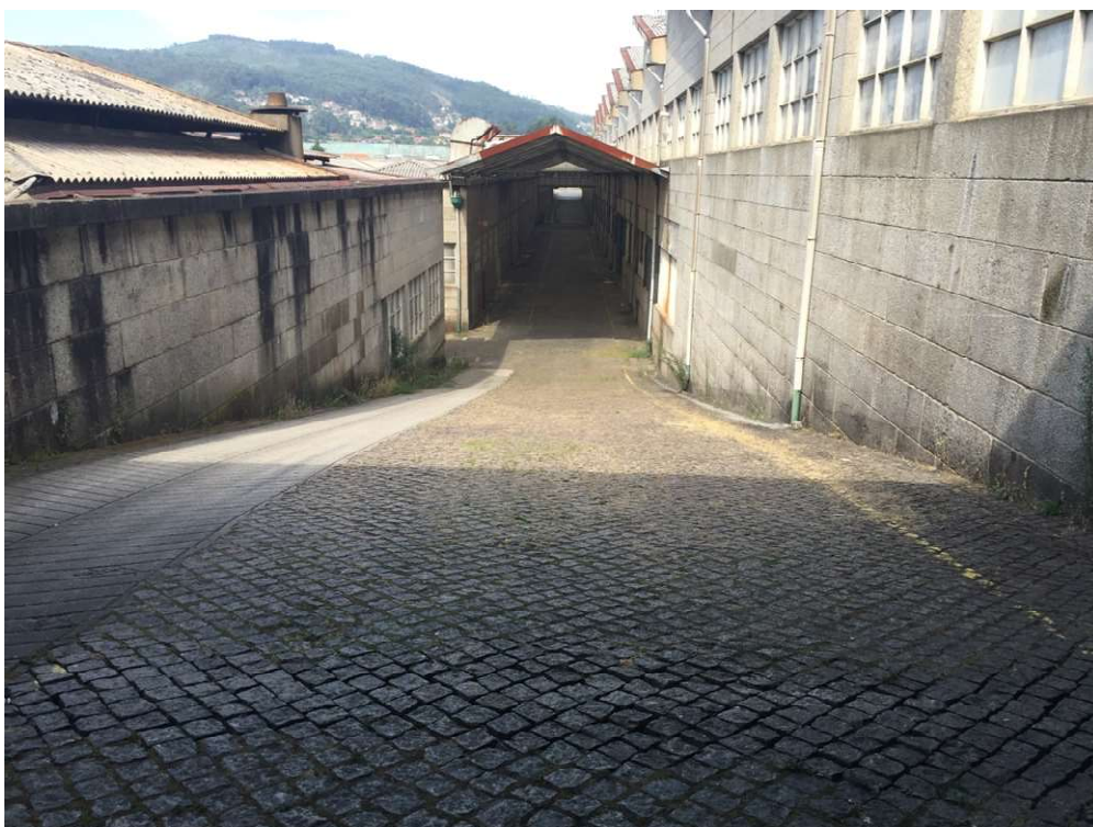
3 Rampa de acesso a piso subterrâneo
