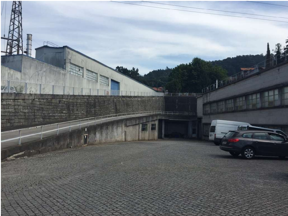
1 Localização da área em estudo. Vê-se que foi realizada a escavação de grande quantidade de camada geológica para implantação dos armazéns
