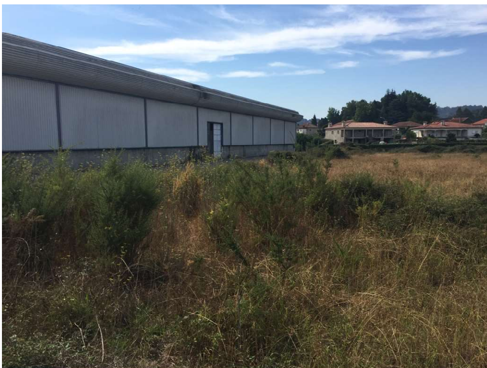
4 Aspecto exterior dos armazéns
