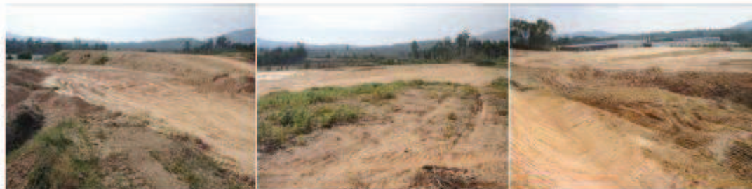
Fotografia 4 – Vista da zona Norte da ampliação com nível de aterros.
