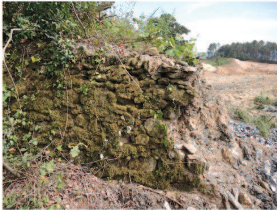
Fot.11 – Pormenor da estrutura, Sítio n.º 1,
