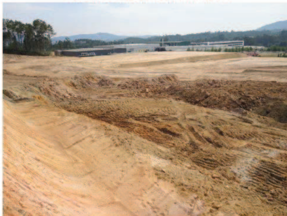
Fot.6 - Vista geral da área de ampliação já com grandes terraplanagens e uma unidade já construída.
