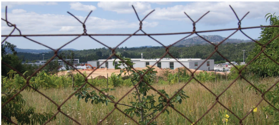
Figura 10 - Vista parcial sobre o PEL a partir do limite nascente, junto de habitações no lugar de Monte (ponto 224 na Carta 15).
