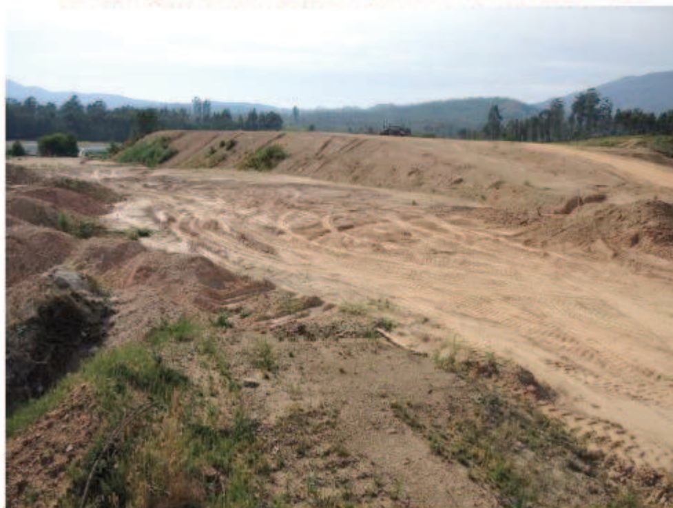
Fot.4 - Vista da zona Norte da ampliação com nível de aterros.
