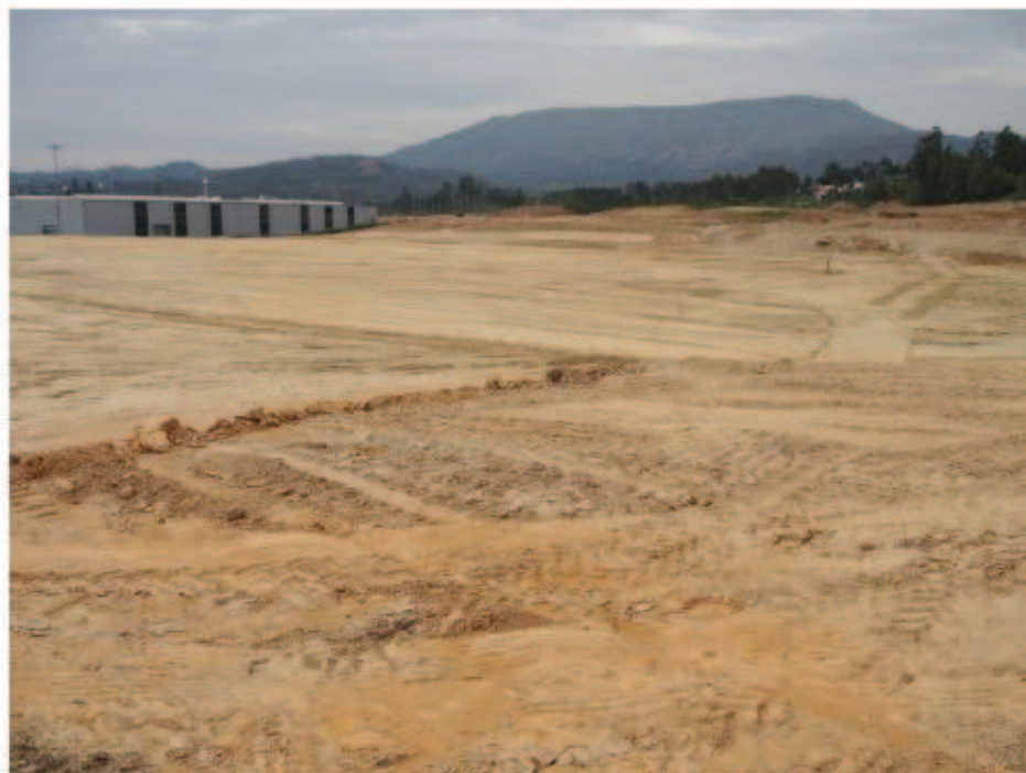
Fot.1 –Vista geral da área Este do Parque, com grandes áreas terraplanadas.
