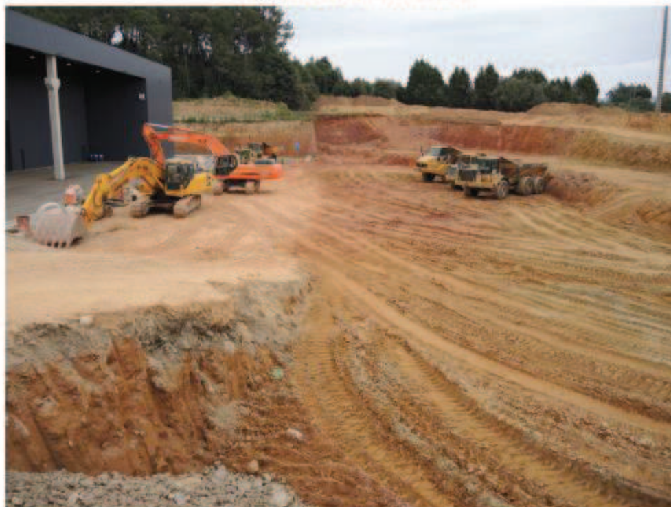
Fot.8 - Área a SE onde actualmente se encontram a decorrer trabalhos de escavação.
