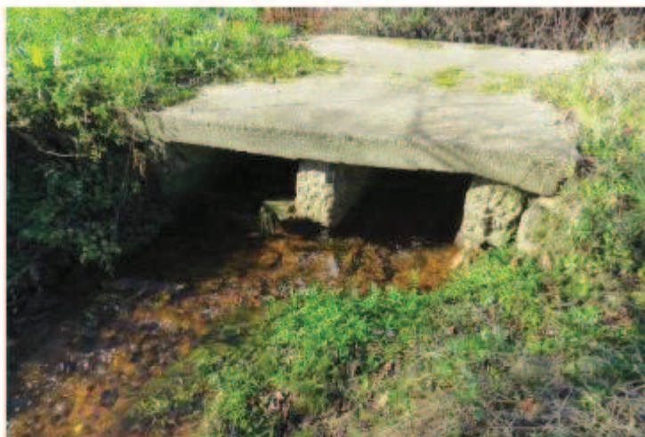
Fig. 8 – Passagem de reduzida dimensão a montante da PH sob o CM1185
