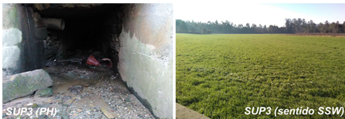
Figura 4. Passagem hidráulica (PH) sob EN506 e aspeto da paisagem a jusante desta PH (21/12/2017).
