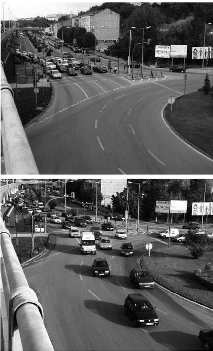
Figura 16 - Exemplo de solução geométrica deficiente numa entrada de uma rotunda
