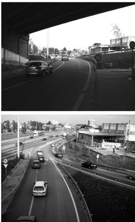
Figura 15 - Exemplo de solução deficiente na compatibilização planta-perfil num nó de ligação
