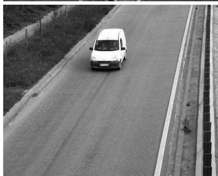
Figura 12 - Exemplo de Via Rápida com marcas rodoviárias deficientes do pavimento
