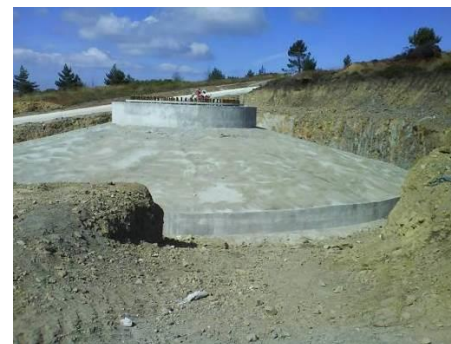
Fundação betonada e pronta para ser aterrada
