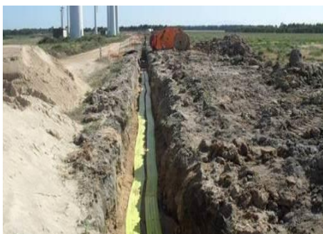
Colocação das lajetas de proteção mecânica
