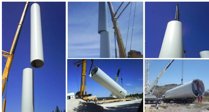
Trabalhos de montagem da torre de um aerogerador
