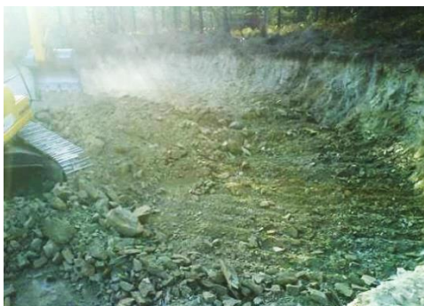
Escavação do cabouco
