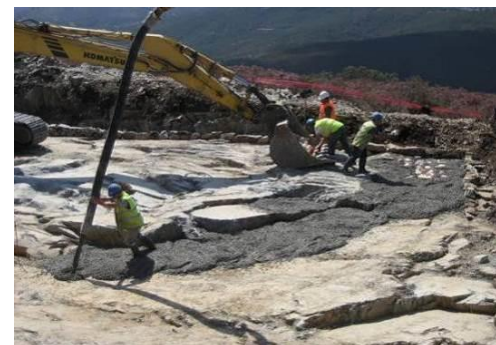
Betonagem de betão de limpeza na fundação
