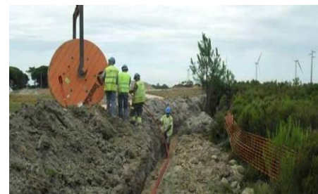
Colocação de Cabo
