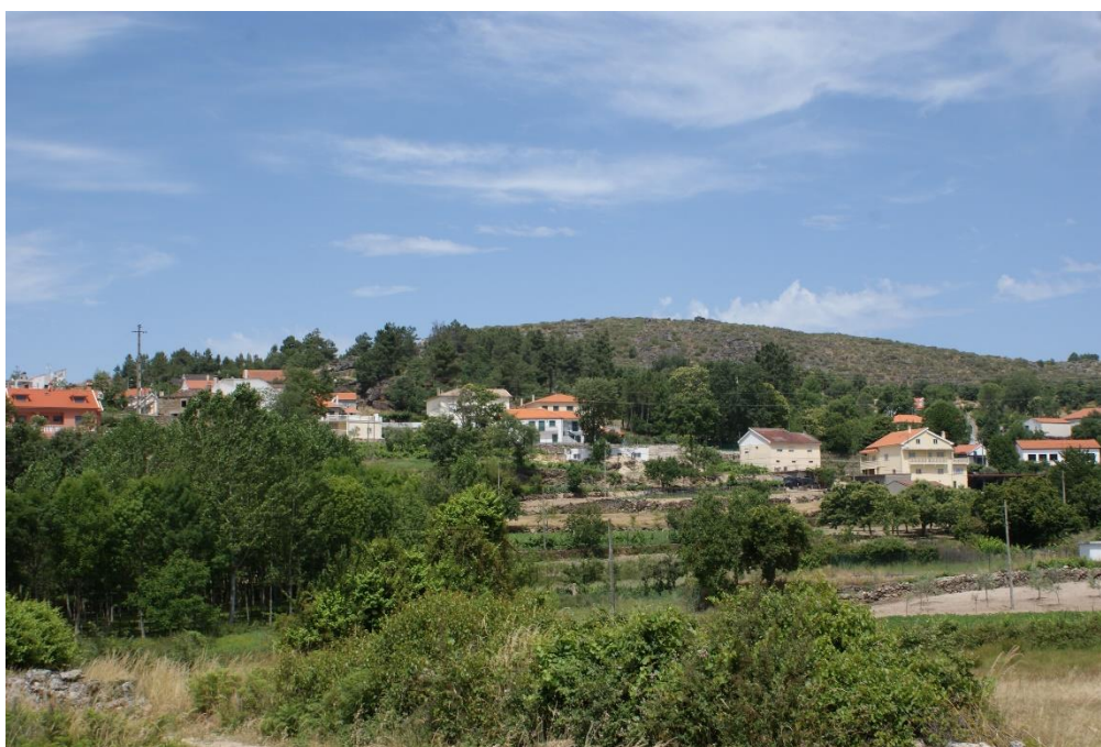
Figura 17: Área social em relevo ondulado e/ou acidentado, povoação de Chosendo.
