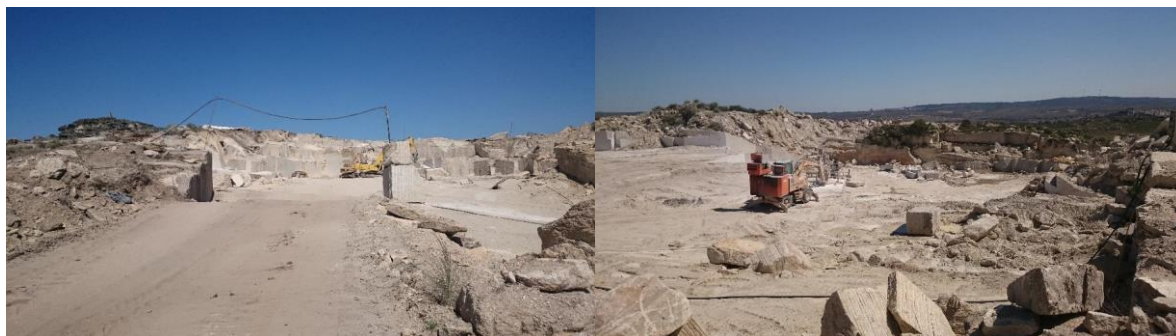
Figura 91: Registo fotográfico da zona de visibilidade A.
