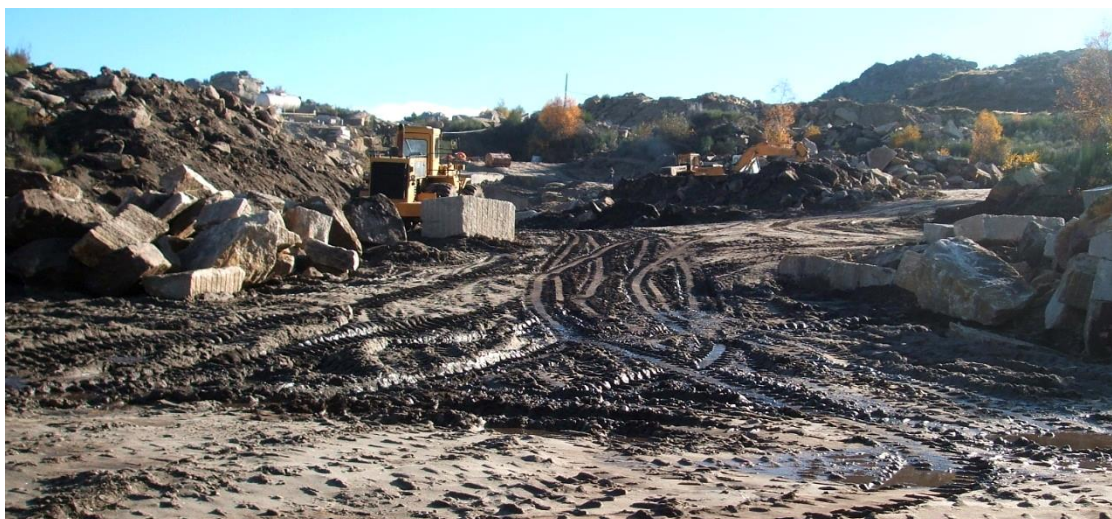
Figura 84: Vista do interior da zona de intervenção.
