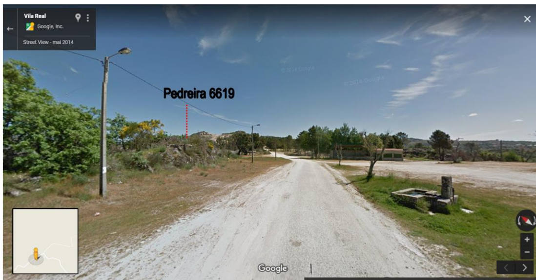
Figura 13: Ponto 1 (ver Figura 12) - Acesso à entrada principal da Pedreira n.º 6619 “Plaina das Queirogas” (350m de distância em linha reta).
