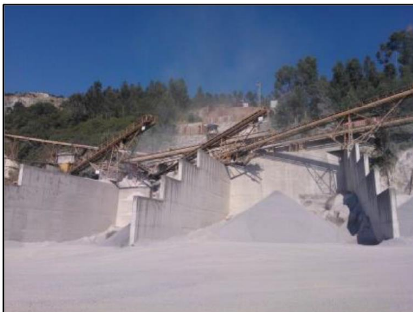
Figura 7: Vista parcial da instalação de britagem
