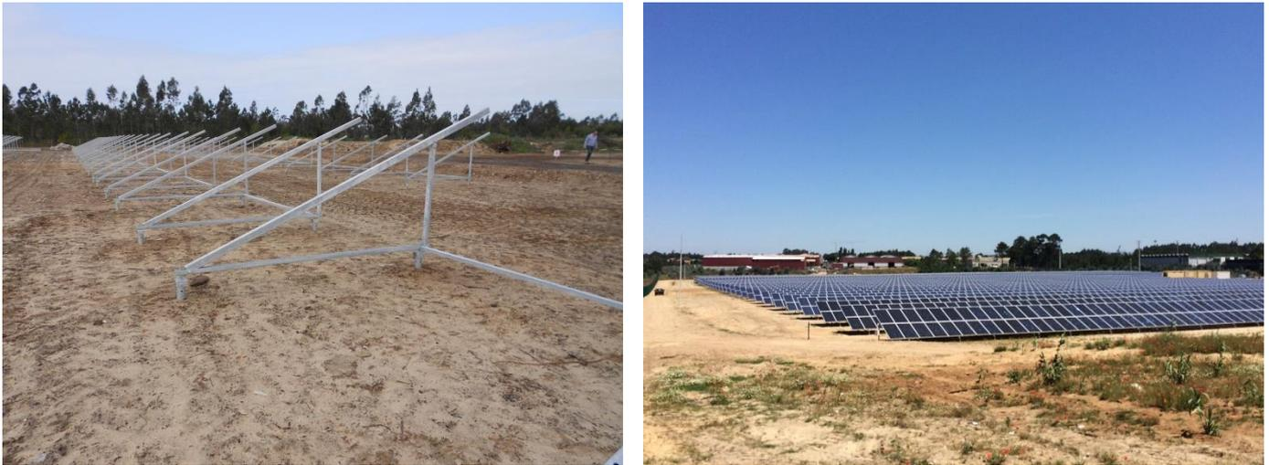
**Figura 6:** Montagem das estruturas de suporte às mesas de painéis fotovoltaicos e Painéis fotovoltaicos instalados (da esquerda para a direita).
