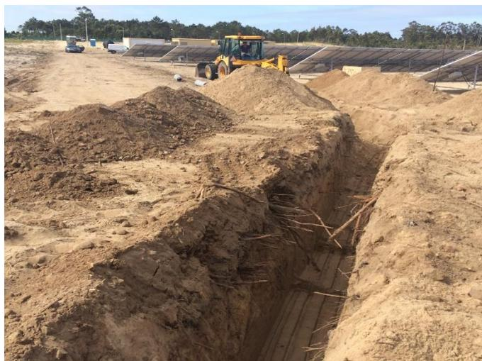
**Figura 4:** Exemplos de aberturas das valas para a rede de cabos subterrâneos numa Central Fotovoltaica.
