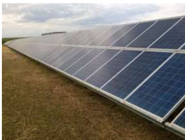
Fotografia 3 – Exemplo de módulos fotovoltaicos
