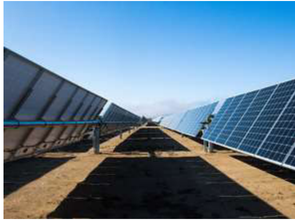
Fotografia 4 – Exemplo de estrutura com seguidor de um eixo
