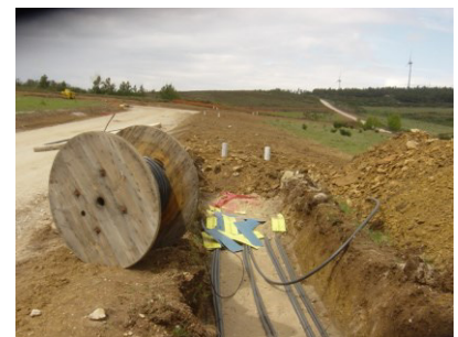
Fotografia 12 - Colocação dos cabos
