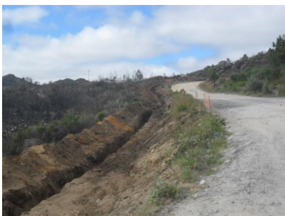
Fotografia 10 - Abertura da vala
