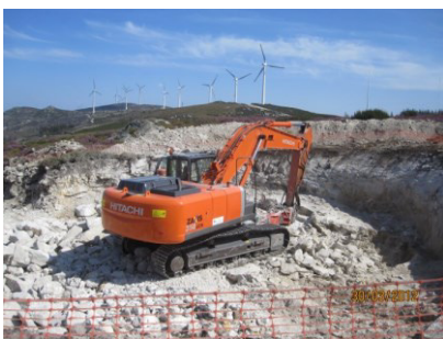
Fotografia 2 - Abertura do cabouco para a fundação do aerogerador
