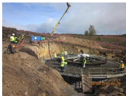
Fotografia 3 - Execução da armadura da fundação do aerogerador
