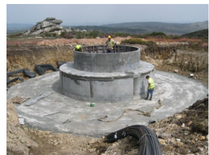
Fotografia 4 - Betonagem da fundação do aerogerador
