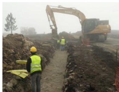
Fotografia 11 - Execução da base em areia
