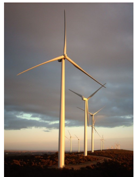
Fotografia 1 – Estrutura de um aerogerador
