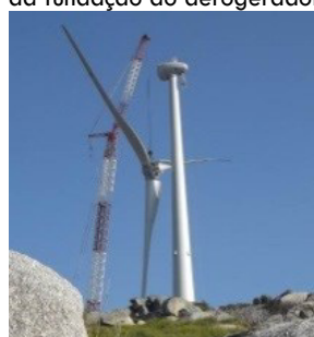
Fotografia 6 - Montagem da cabina do aerogerador com as pás
