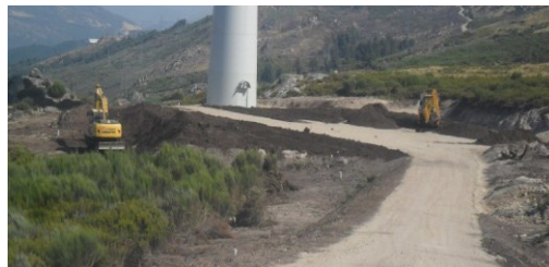
Fotografia 8 - Trabalhos de requalificação da plataforma de montagem de um aerogerador
