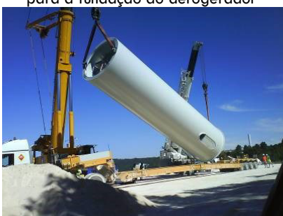
Fotografia 5 - Montagem da torre do aerogerador
