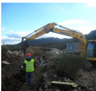
Fotografia 13 - Fecho da vala
