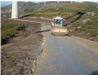
Fotografia 7 - Trabalhos de compactação do acesso após requalificação dos taludes
