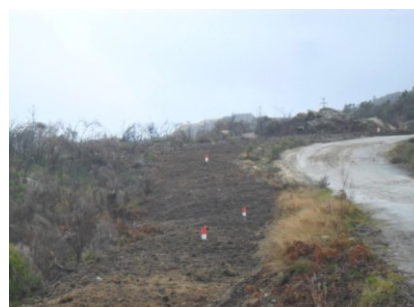
Fotografia 14 - Aspecto final da vala de cabos
