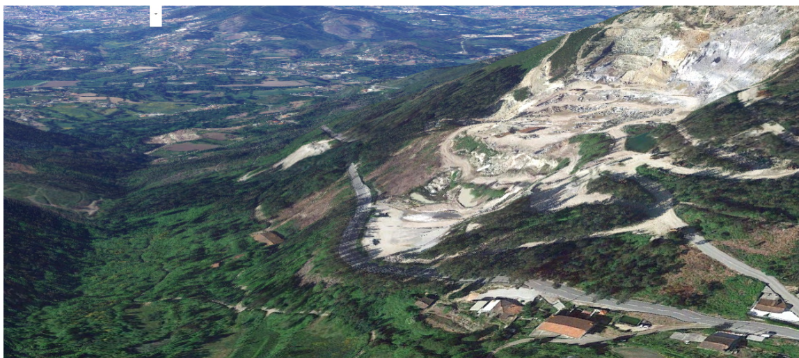
Figura 38: Localização da zona de intervenção em flanco de encosta no Monte de Gonça em territórios sobre-elevados relativamente ao vale aluvionar
