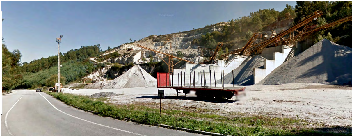
Figura 39: Vista geral da zona de intervenção ao nível da estrada
