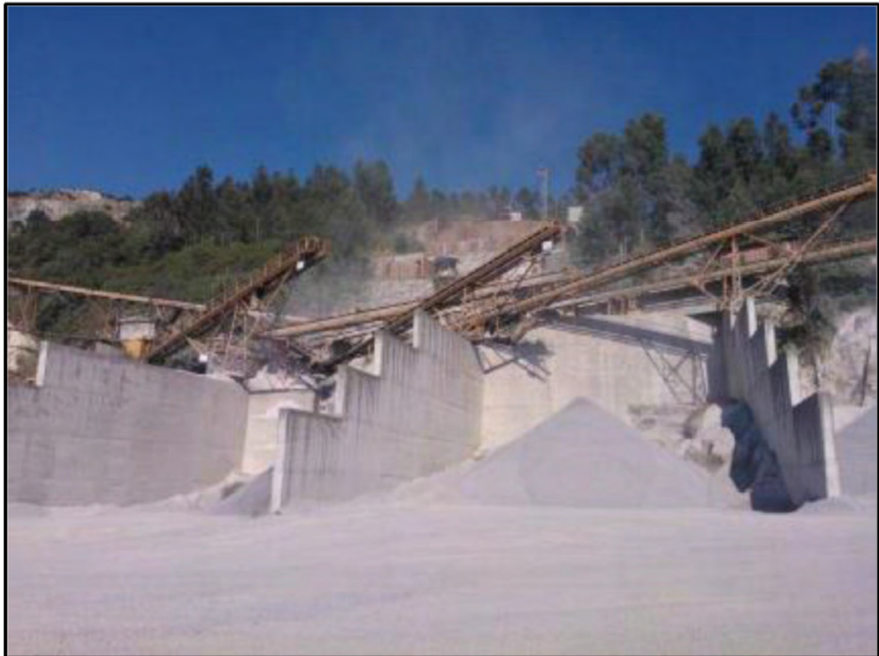
Figura 10: Vista parcial da instalação de britagem
