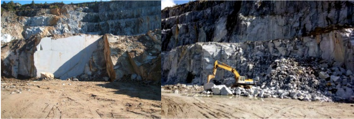
Figuras 36 e 37: Situação de corte com fio diamantado (à esq.) e desmonte com explosivos (à direita).
