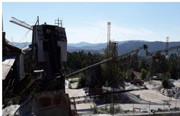
O sistema de produção de agregados inicia-se no ponto de descarga dos dumpers vindos das frentes de desmonte. A descarga é feita para uma tremonha composta por um alimentador que fornece um caudal de alimentação ao britador primário.
