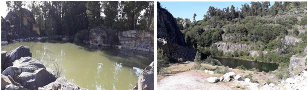
O consumo anual de água limpa pelas atividades industriais acima referidas, incluindo a lavagem de equipamentos e sistemas de despoejamento, é da ordem de 50 000 m<sup>3</sup>. Este quantitativo é composto por cerca de 30% (15 000 m<sup>3</sup>) de água obtida no poço de captação, sendo os restantes 70% de água (35 000 m<sup>3</sup>) obtidos nas bacias escavadas de retenção de águas pluviais.
