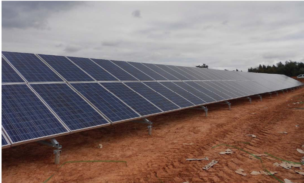
Fotografia 3.1 - Exemplo de fixação ao solo por estacaria.
