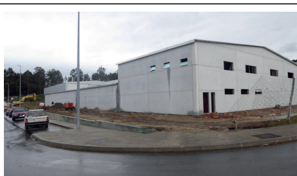
Foto 3 – Construção do edifício da Valver Portugal
