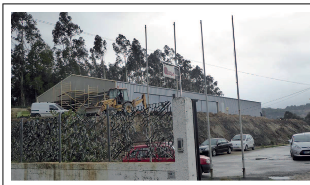
Foto 2 – Construção da cantina da Kyaia
