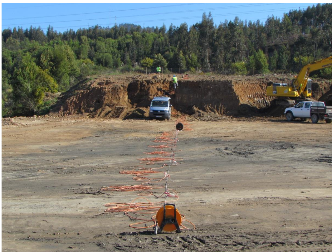
Figura 1.1 – Aspeto dos trabalhos em março de 2015
