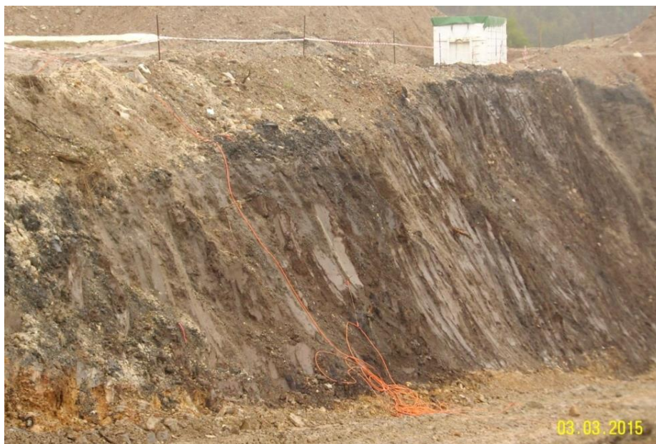
Figura 2.3 – Aspeto do talude de escavação atravessado pelo perfil P3 (identificável pela posição do cabo de cor laranja), cerca dos 20 m do perfil, onde é visível a massa de resíduos
